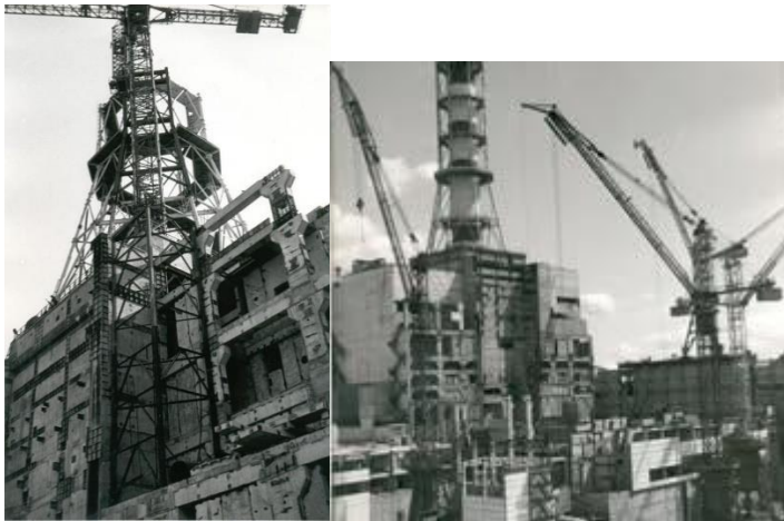
A 3-as és 4-es blokk építési folyamatai. 8
