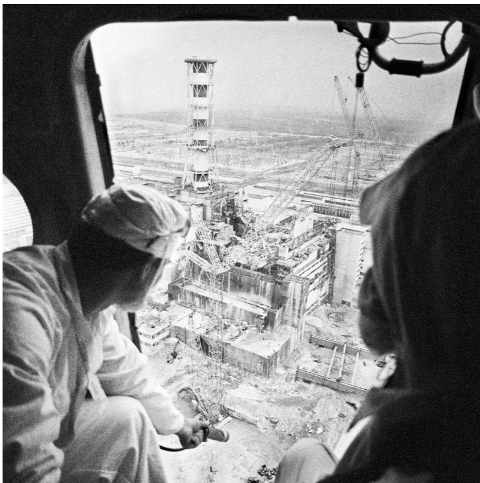
A 4-es reaktor fölé tervezett szarkofág építés alatt. 26
