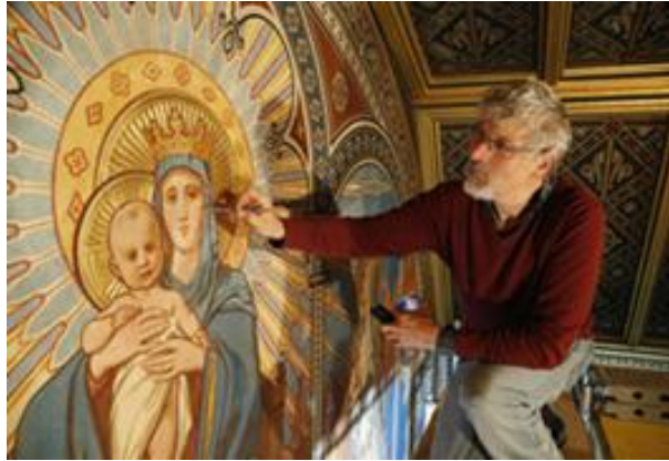
7. ábra: A Mária-kápolna restaurálási munkálatai 2018-ban Forrás: PécsMa
